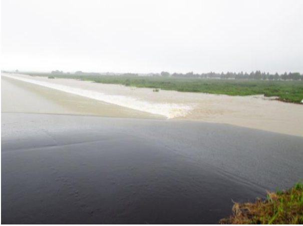
渡良瀬川より第一調節池に越流堤から流入しています。
