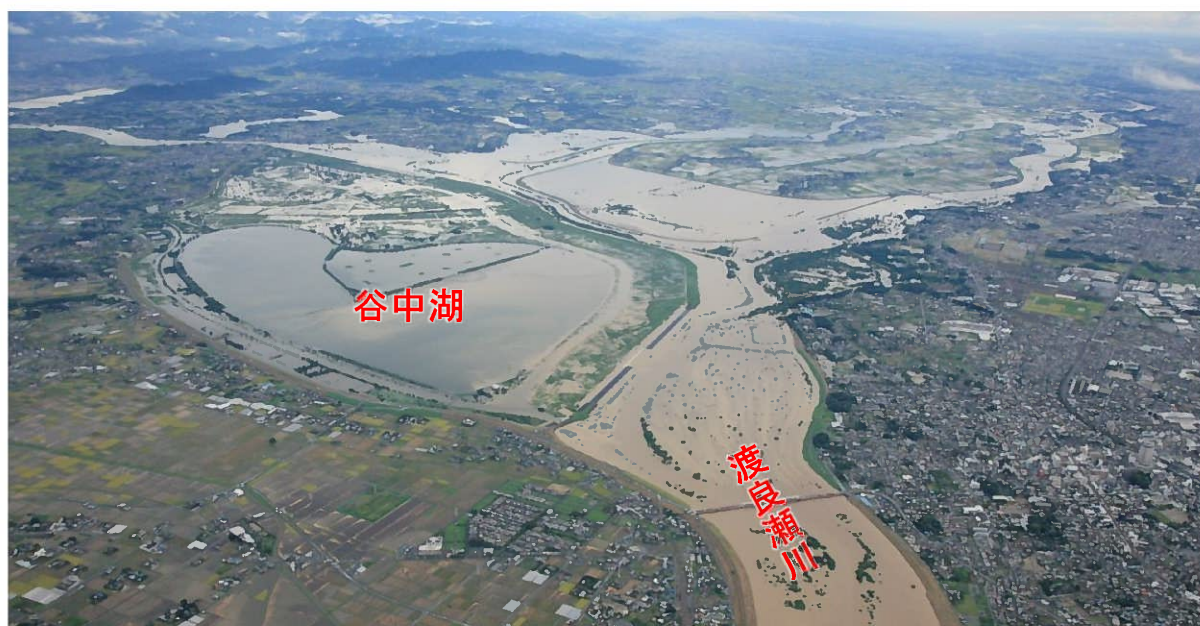
渡良瀬遊水地浸水状況
