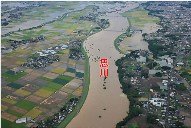
思川出水状況
