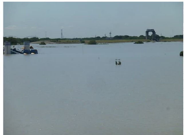
第3調節池貯留状況 9/11
