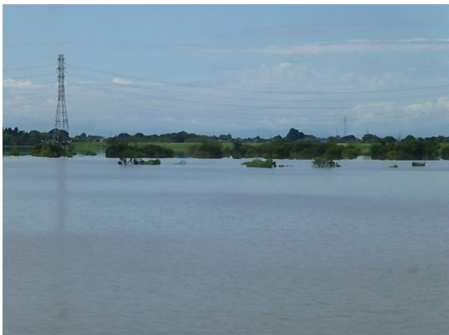
第2調節池貯留状況 9/11
