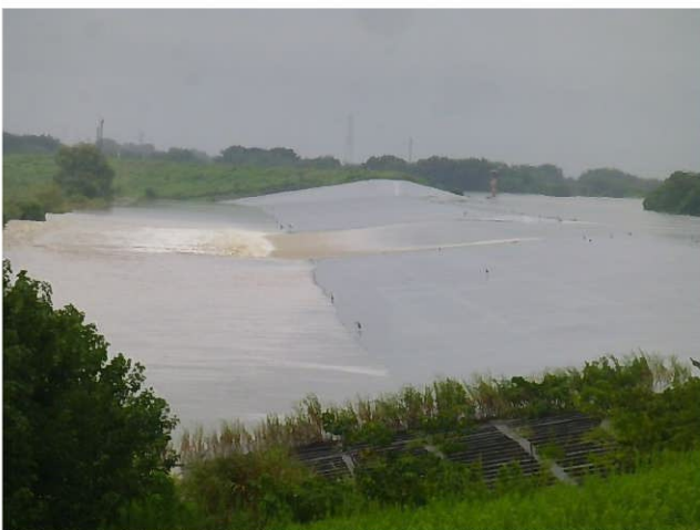
第1調節池上流越流状況
