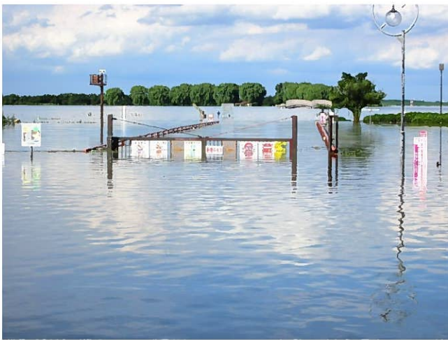
下宮入口の浸水状況 9/11
