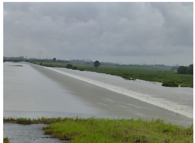
第1調節池上流越流状況
