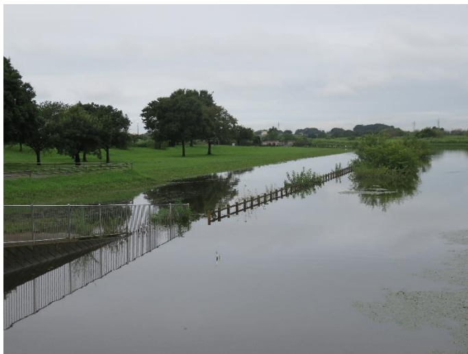
池内水路状況
