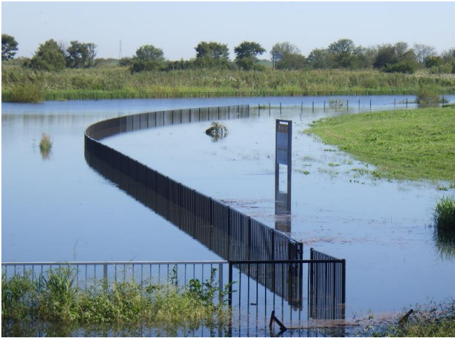
北水門より 子供広場ゾーン
