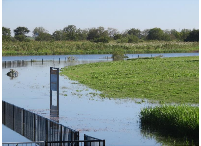
北水門より 子供広場ゾーン
