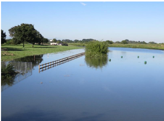
西谷中橋より池内水路
