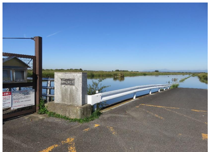
東谷中橋より池内水路
